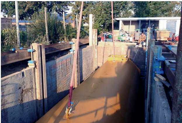
A: Außengurtbefestigung M 36 Position fixiert
